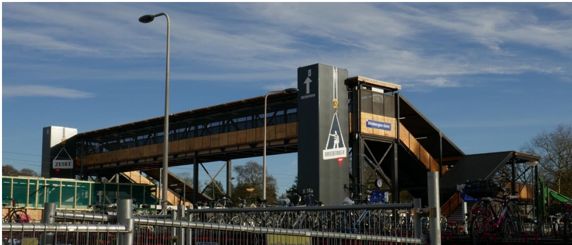
Figuur 4 Referentieproject traverse station Driebergen-Zeist, foto Martijn Zegers 21 januari 2018
